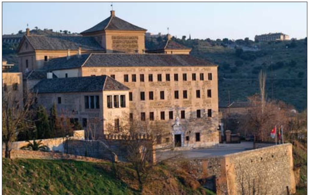
Convento de San Gil, sede actual de las Cortes de Castilla-La Mancha.
