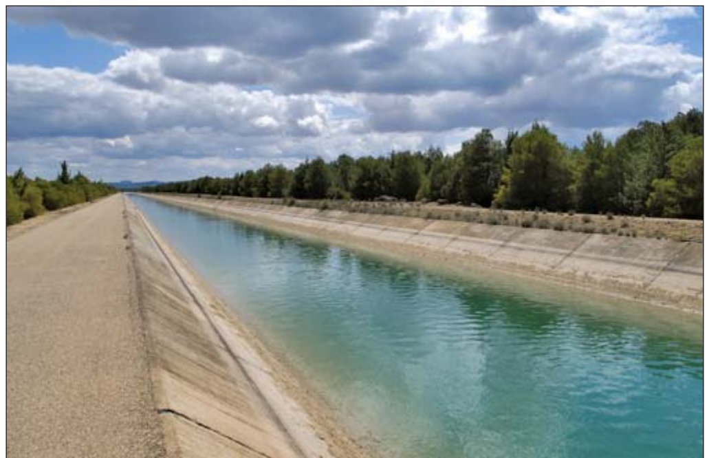
Trasvase Tajo-Segura, una infraestructura que tiene fecha de caducidad, será en el año 2012. →
