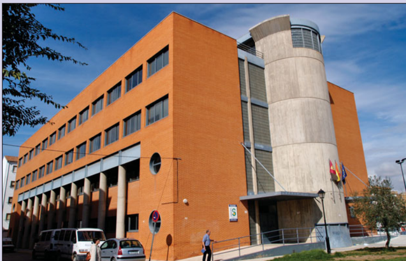
Entre otras infraestructuras, se construirán 37 nuevos centros de salud y 3 consultorios locales en distintos puntos de Castilla-La Mancha. Foto: Centro de Salud en Albacete.
