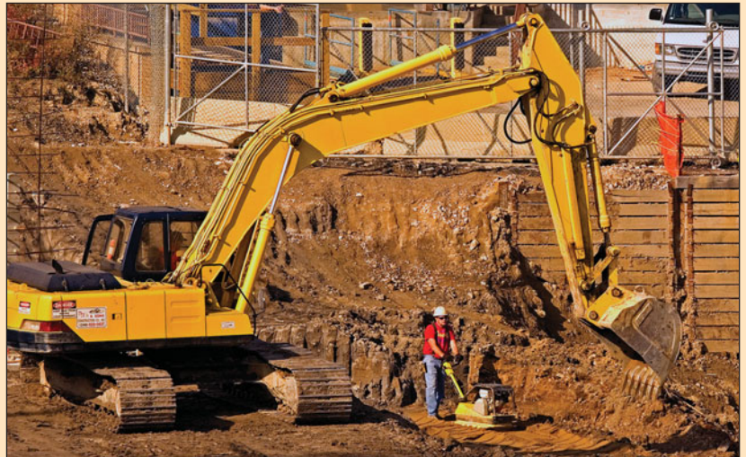
A nivel regional, los recursos de la consejería de Ordenación del Territorio y Vivienda crecerán un 2,56% el próximo año con el objetivo de suavizar el descenso de la actividad en la construcción.
