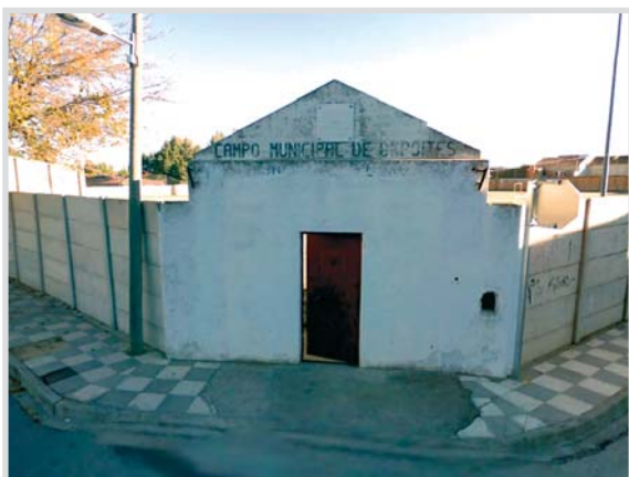
Antiguo campo de fútbol, donde se construirá el centro de salud.
