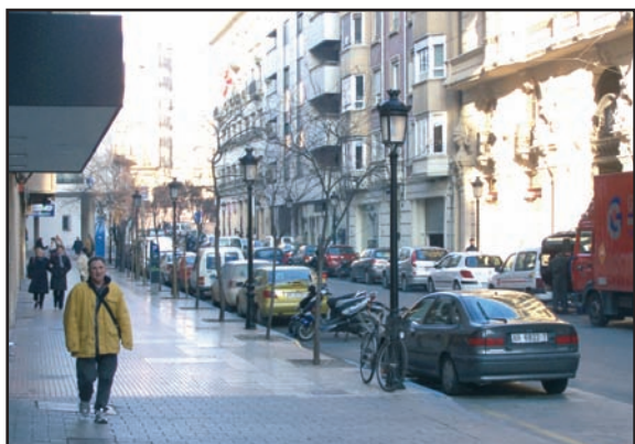
Aspecto de la calle del Tinte, ya remodelada, similar al que tendrán las nuevas.
