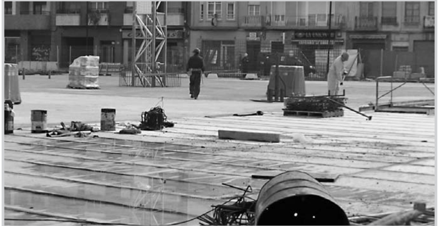
Estado actual de las obras del aparcamiento de la Central Contable.
