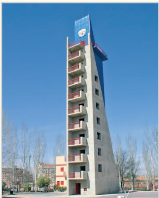
Edificio de Formación del Parque de Bomberos.
