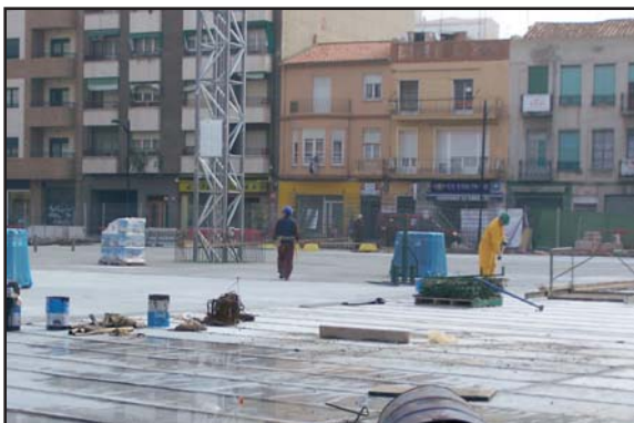
Aspecto actual de las obras de la Central Contable.
