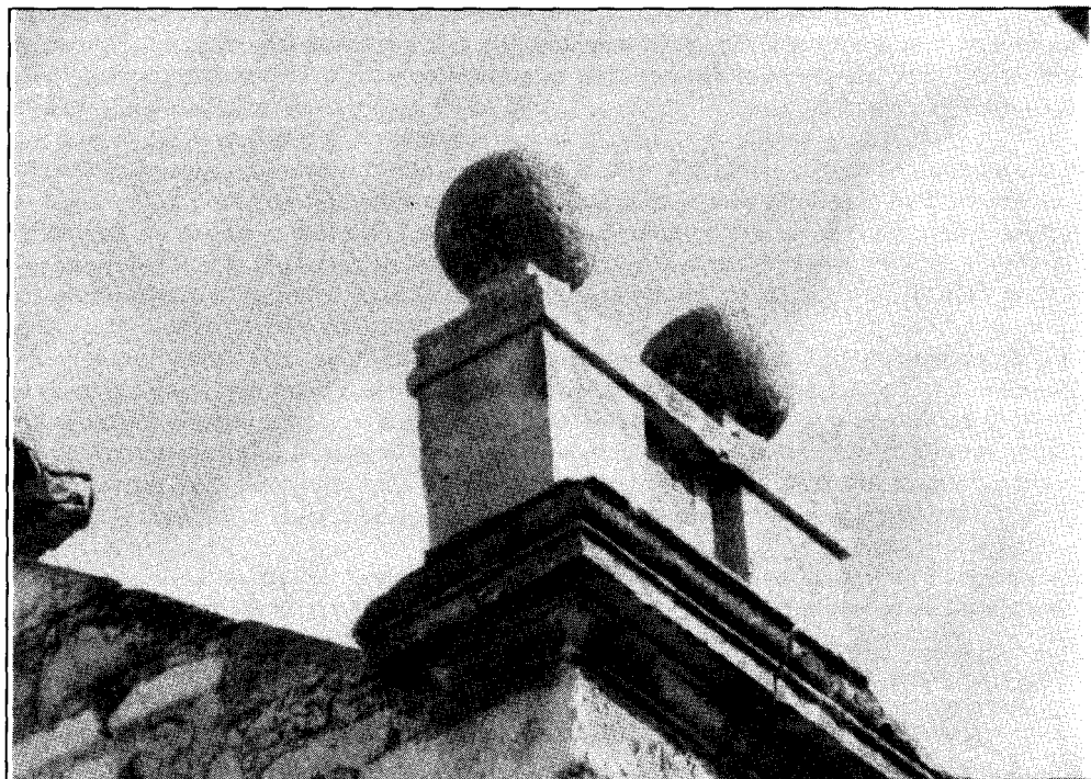
5. Bolas de cantería sobre el segundo contrafuerte del muro SO
