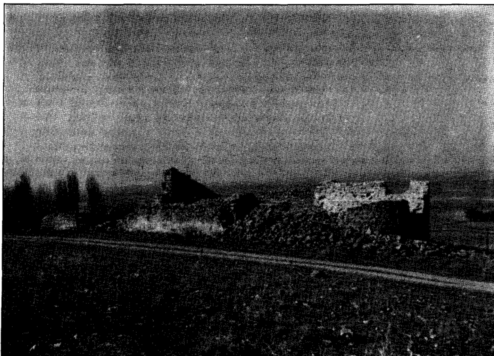
Foto N° 1. Estado actual de Ntra. Sra. de Torres
