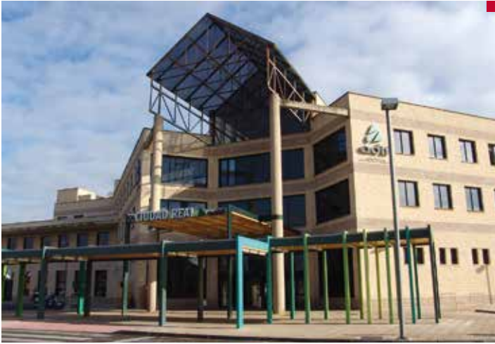
■ Estación de AVE en Ciudad Real.
