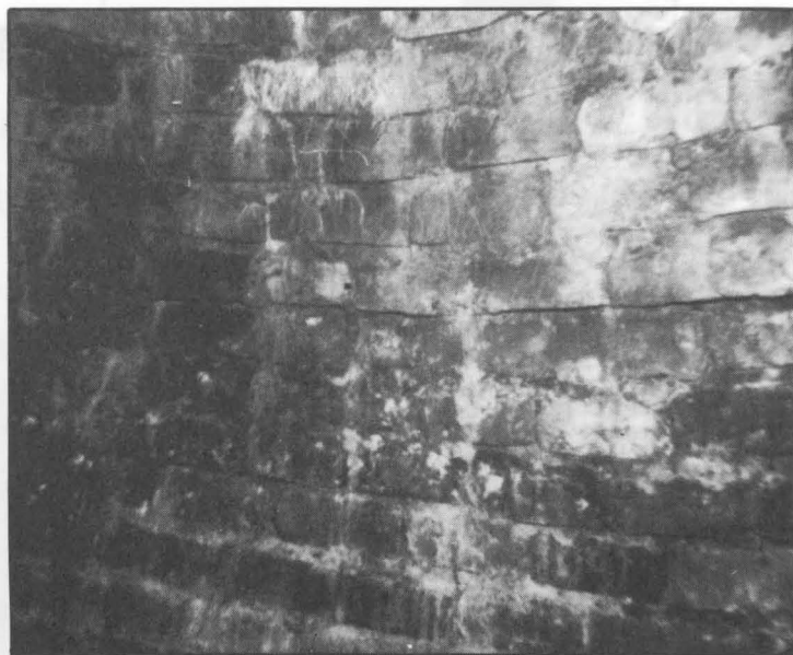
Elementos del horno. Paños para retener la temperatura, palo de hierro, rastrillo, garcho, pala Detalle de las paredes interiores.
