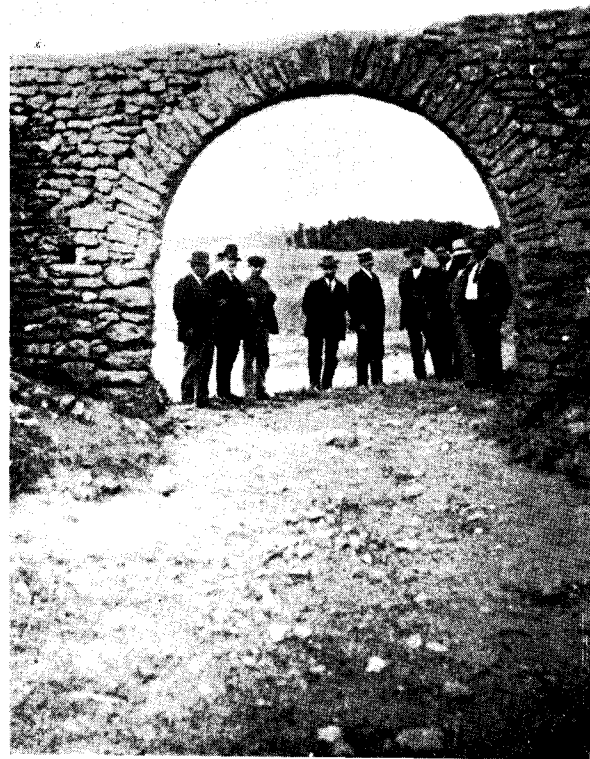
Lam. 21 bis. (pág. 140) Arco de la Antigua Fortaleza de Villajos.
