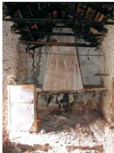
Interior de casilla quincallería.
