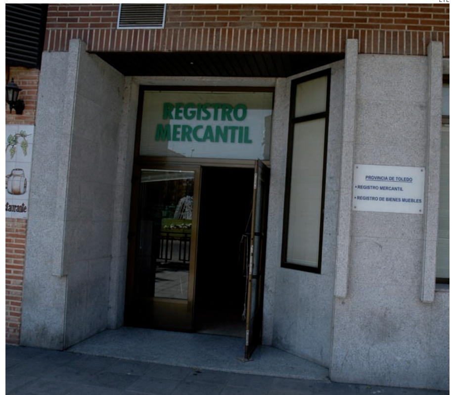
Edificio del Registro Mercantil de Toledo capital.
