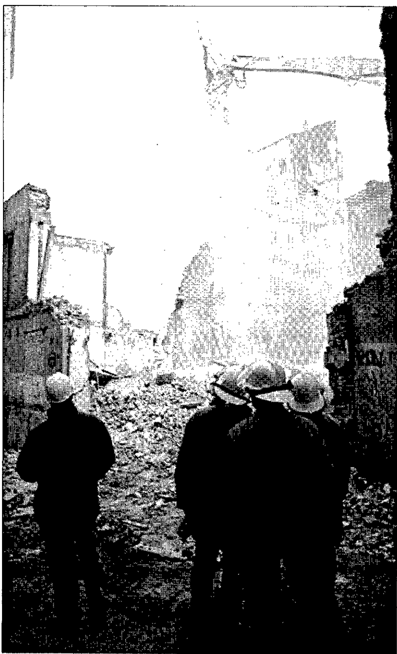
ANTIGUA Imagen de la casa que se derrumbó en la madrugada de ayer en la calle Limón.
