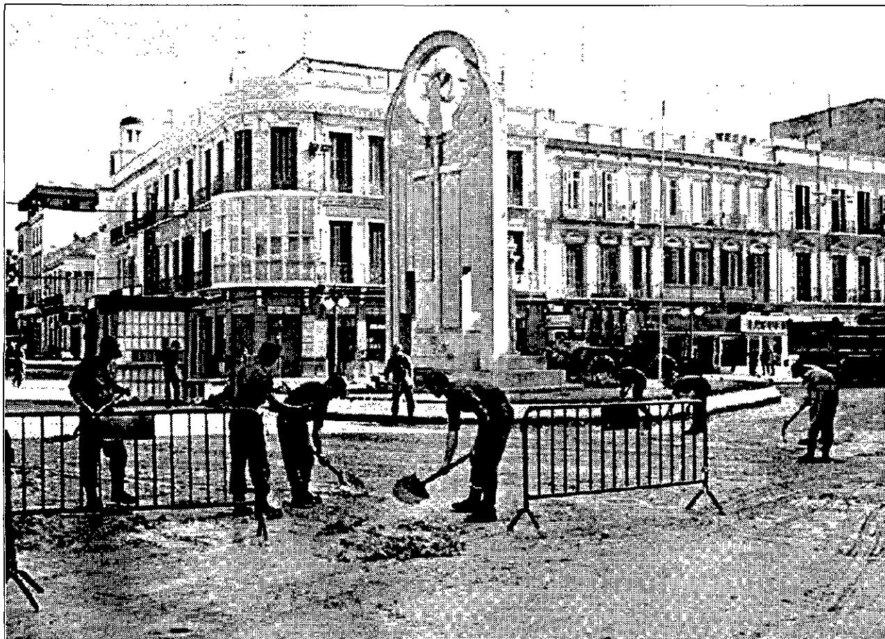
REPARACIÓN Un grupo de soldados trabaja en labores de reparación en una de las calles melillenses afectadas por la riada artificial.
