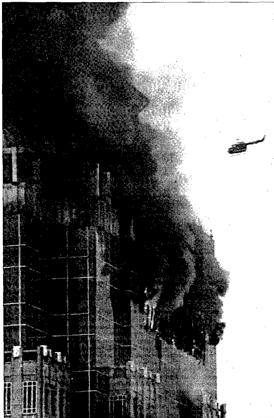
APARATOSO Un helicóptero sobrevuela el edificio siniestrado, del que sale una intensa columna de humo.
