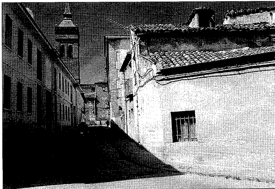
La actuación será integral en la calle Salazaras, ya que no reúne las condiciones de accesibilidad.
