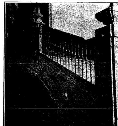
Detalle de la escalera principal
