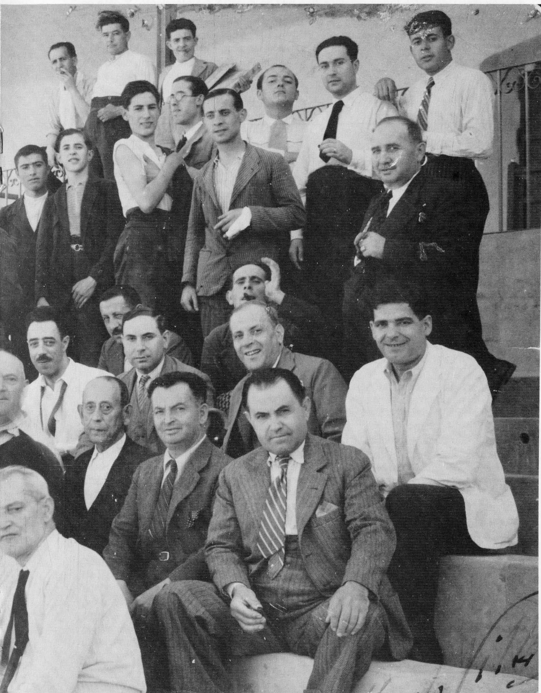
onstrucción. (Fecha aprox. 1933-34). Foto cedida por Julia M. a Nieto
