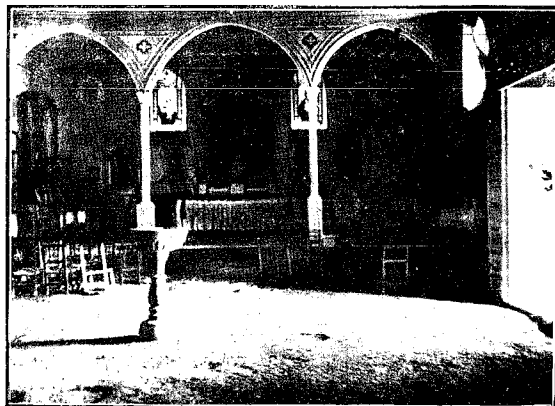
Povedilla.--Interior de la original Iglesia.
