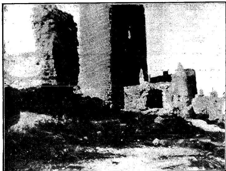
Alcalá del Júcar.--Ruinas del antiguo castillo que cual un avanzado centinela se levantaba en la cumbre, hoy derruido y maltrecho.
