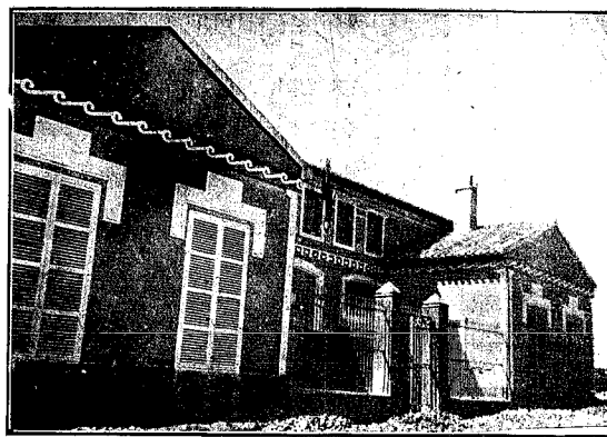
TOBARRA--Vista general del nuevo y magnífico matadero público.
