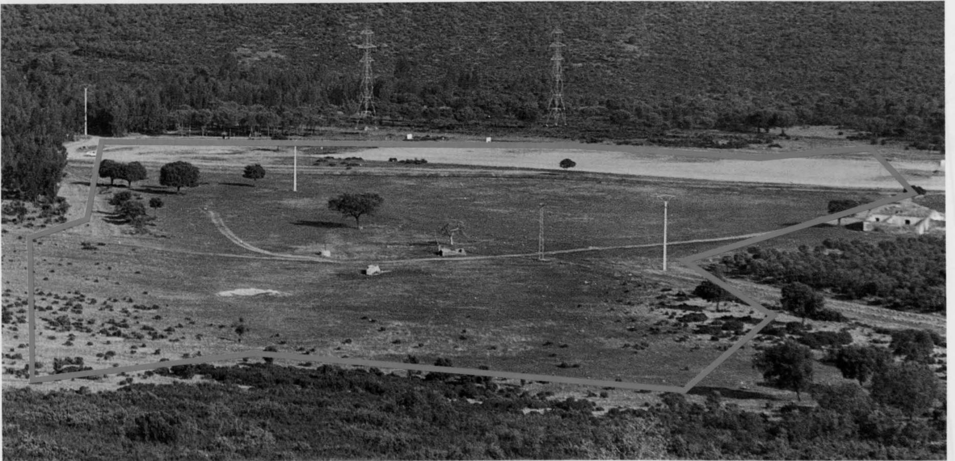
Comenzarán en breve las obras de cerramiento de la Dehesa Boyal, cuya extensión puede apreciarse en la fotografía.
