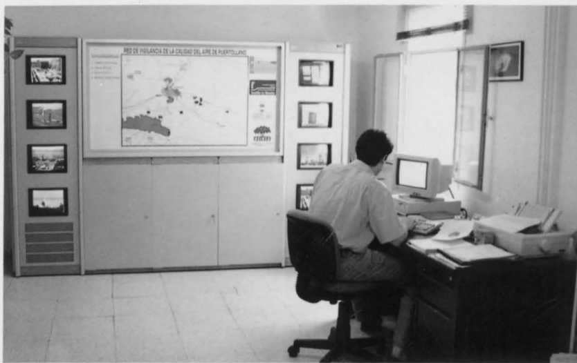
Vista general de la sala de control con los monitores de seguimiento.
