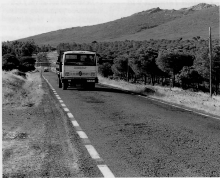
La carretera de Mestanza cuenta con un trazado y firme obsoleto
