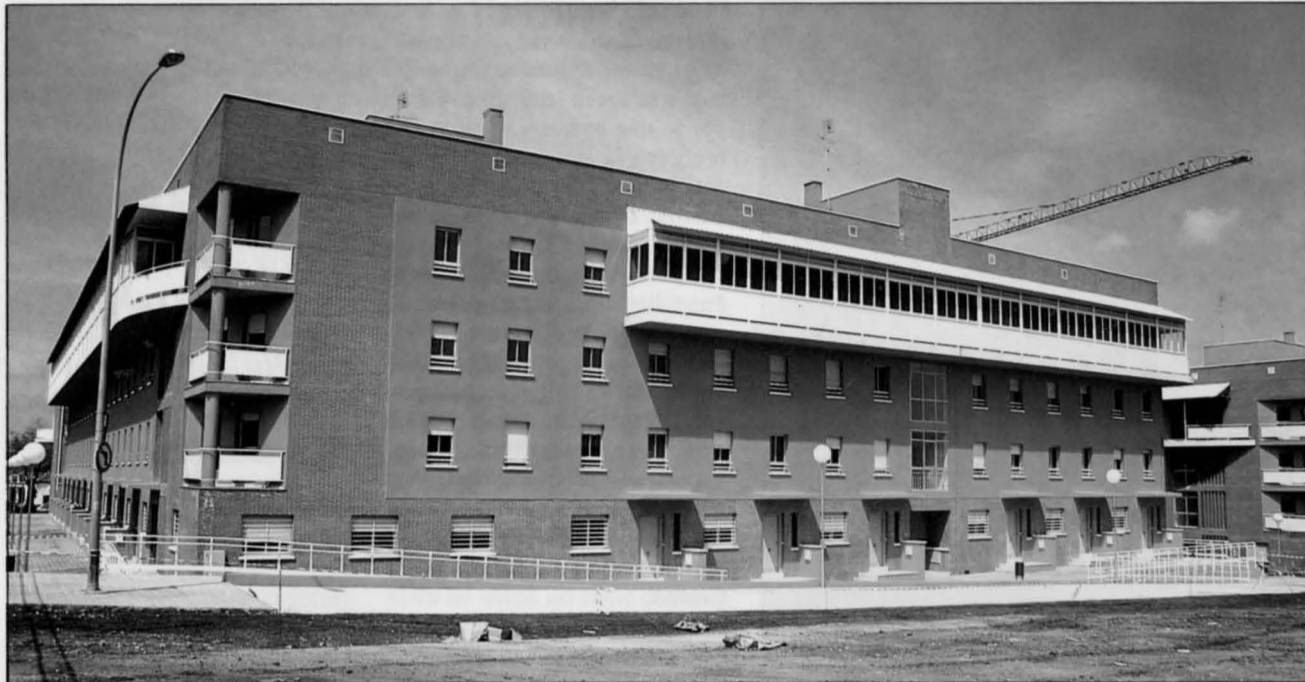
Vista general del nuevo bloque de viviendas ya terminado.
