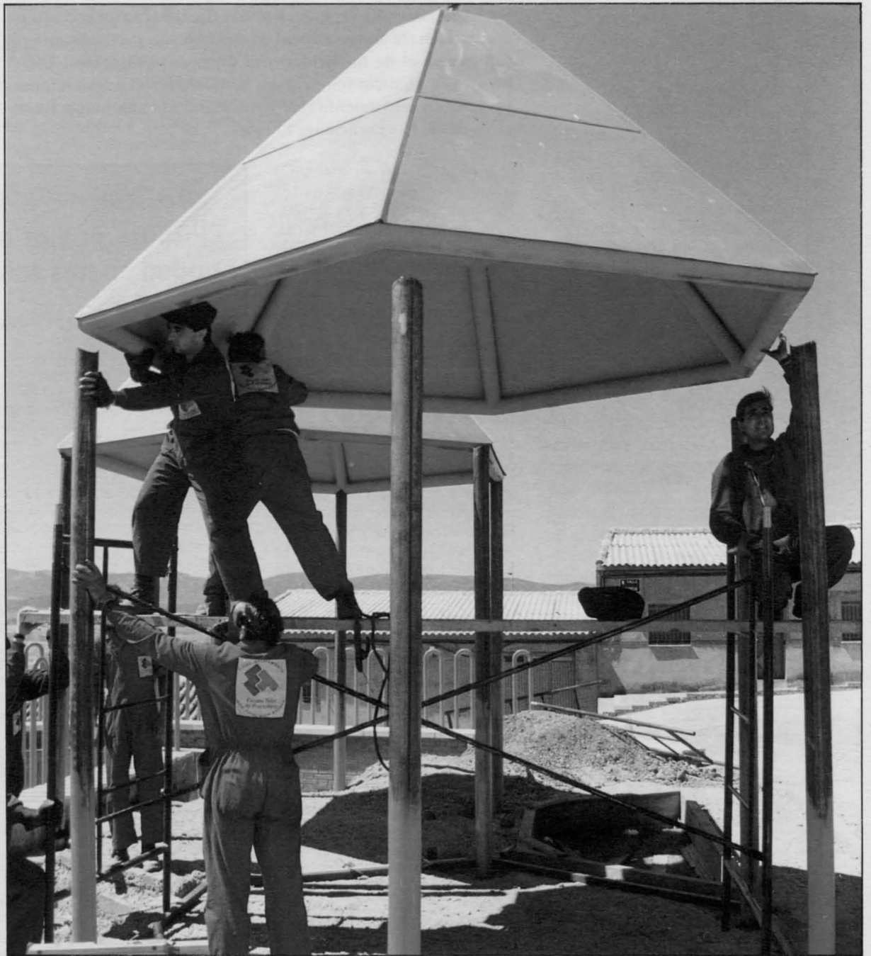
Varios alumnos instalan un templete metálico durante las obras de rehabilitación
