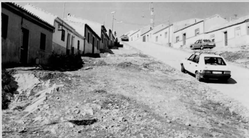
La calle Espronceda (en la fotografía) cambiará su aspecto próximamente con las obras de pavimentación
