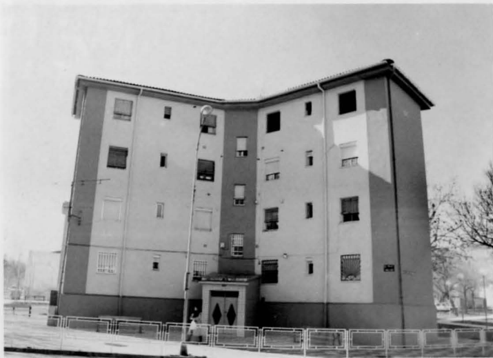
En la fotografía, uno de los bloques de la barriada de las 630 afectadas por la aluminosis
