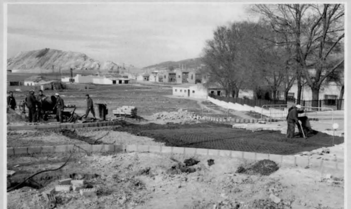
Obras en calzadas, servicios de alcantarillado y bocas de riego de la plaza y calle Calveros
