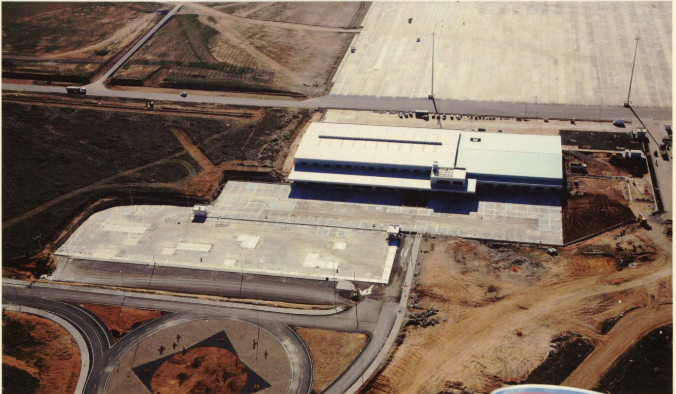
Terminal de carga del Aeropuerto Central Ciudad Real.
