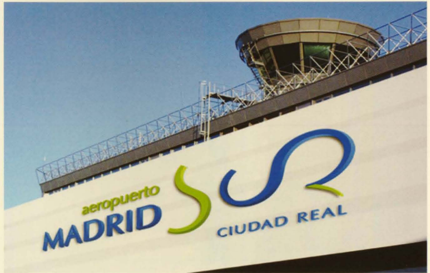
Imagen de las instalaciones aeroportuarias Madrid - Sur Ciudad Real
