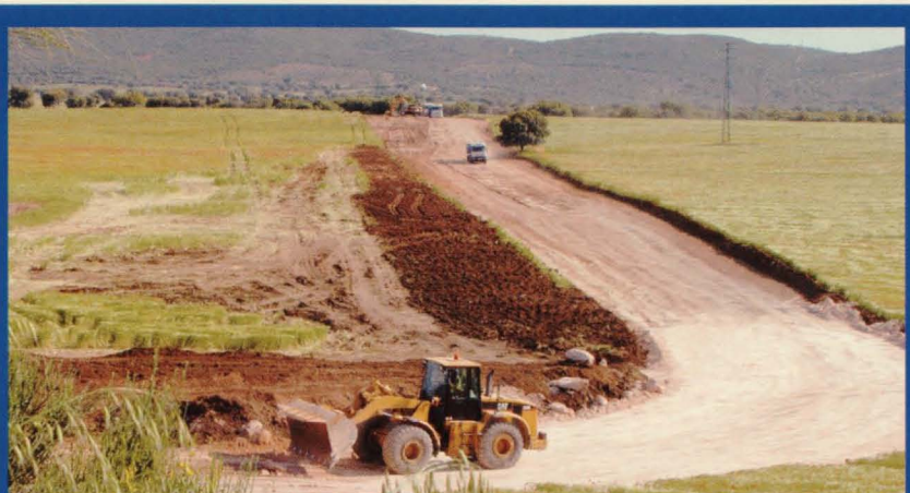
Los movimientos de tierra comenzaron con gran celeridad
