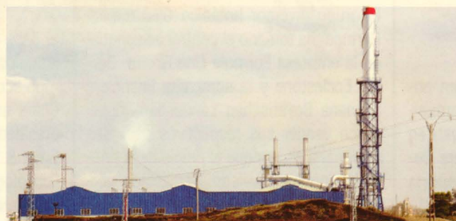
Planta de biomasa de Movialsa en Campo de Criptana.
