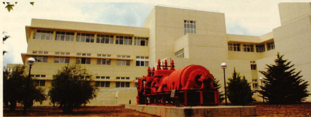
Edificio de la Escuela de Caminos, Canales y Puertos del Campus de Ciudad Real.
