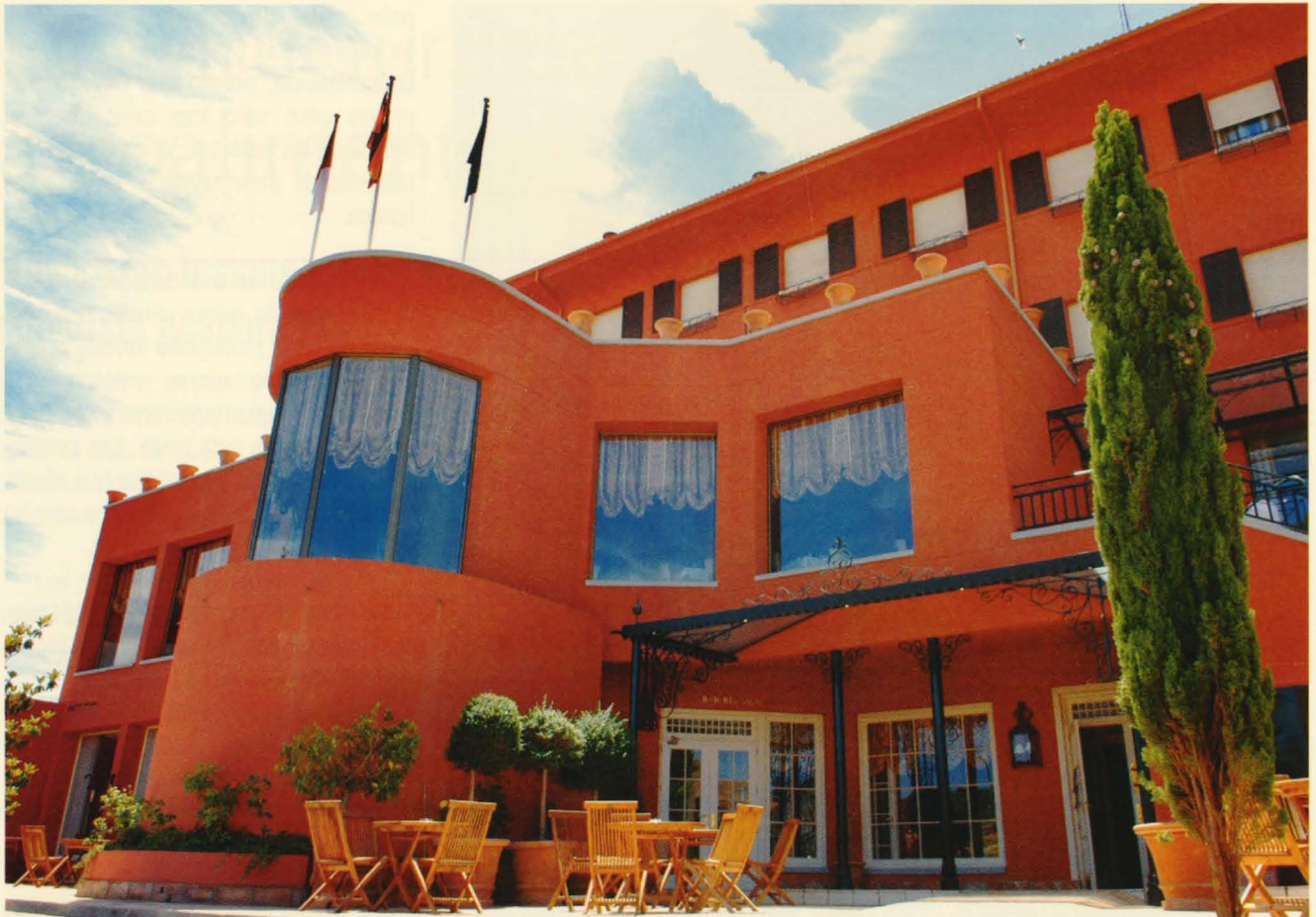
Sobre estas líneas fachada del Hotel Parque Cabañeros, donde la comodidad y el moderno equipamiento se conjuntan con el entorno natural
