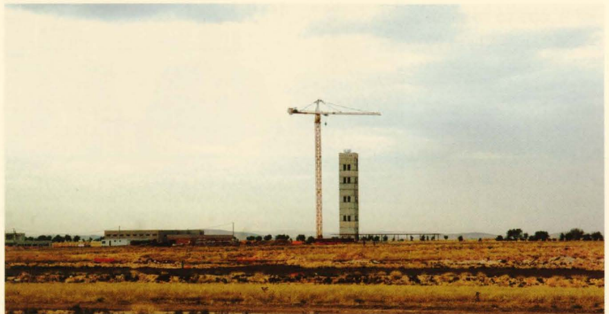
Obras del Aeropuerto Don Quijote de Ciudad Real.
