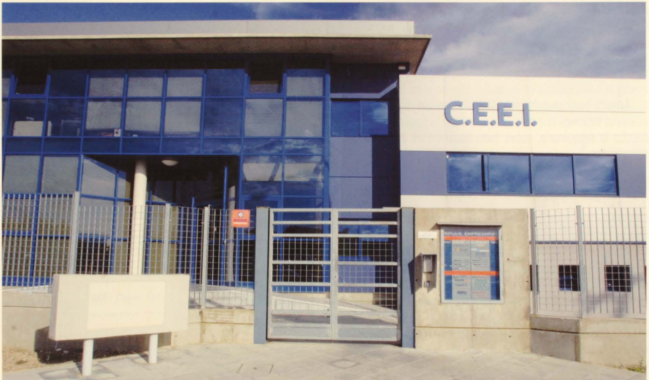
CEEI Ciudad Real ha trabajado intensamente en la creación y el desarrollo de empresas innovadoras. En la imagen el edificio situado en el Polígono Larache.
