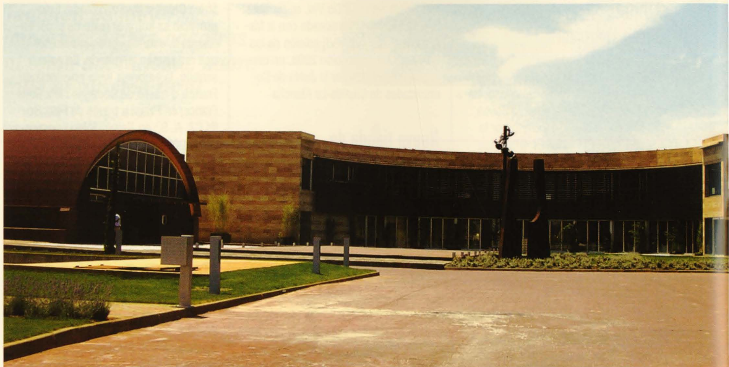
Sobre estas líneas vista general del edificio principal. En la siguiente página, arriba, un rincón de la bodega. Debajo, diversas vistas de las instalaciones.
