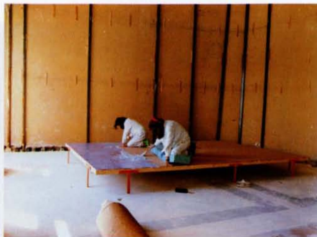
Impermeabilización del corcho
