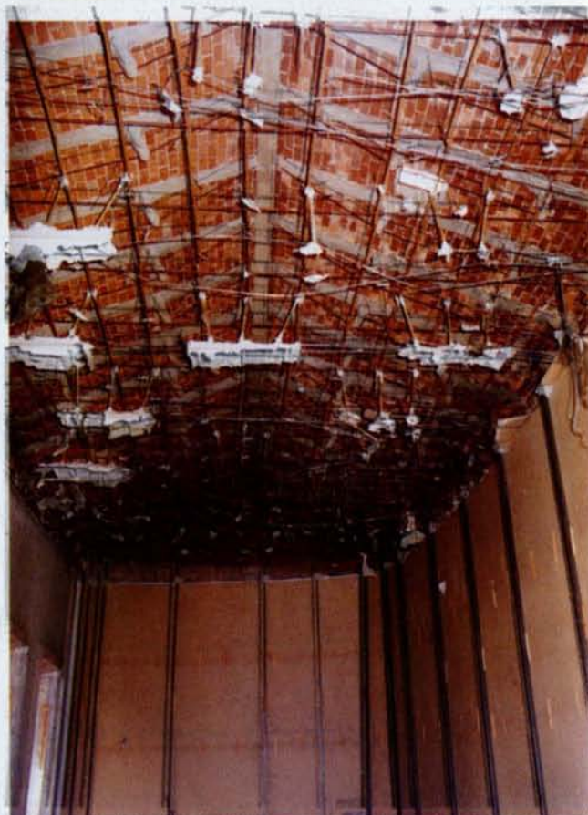
El techo del Salón de Sesiones descubierto para la posterior colocación de los lienzos de Andrade. En la parte inferior elementos de protección del mural de Villaseñor colocado durante el transcurso de las obras.
