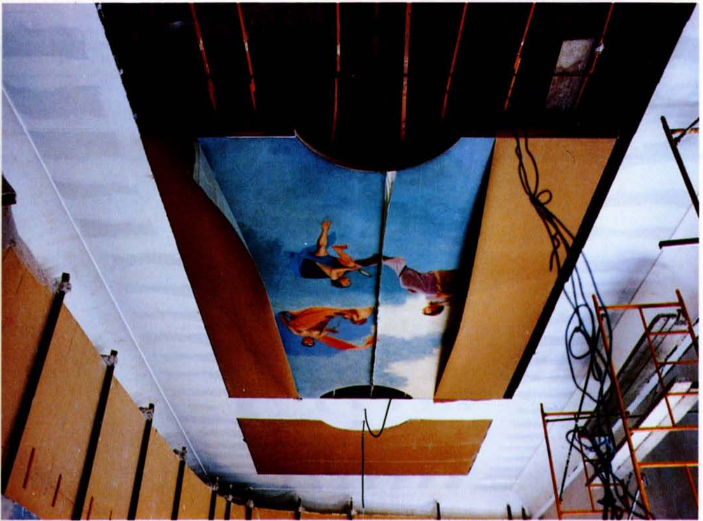
Colocación del lienzo central en el techo del Salón de Sesiones. Al fondo puede verse uno de los lienzos ya colocado y cubierto con panel.
