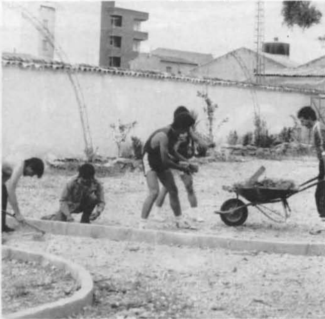
Construyendo los caminos
