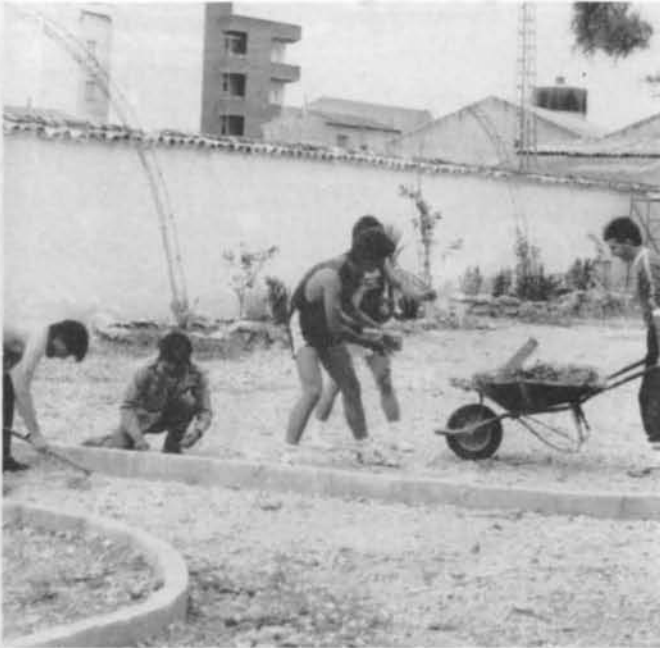
Construyendo los caminos
