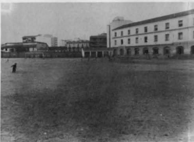
Los hogares provinciales cuentan con amplias instalaciones.
