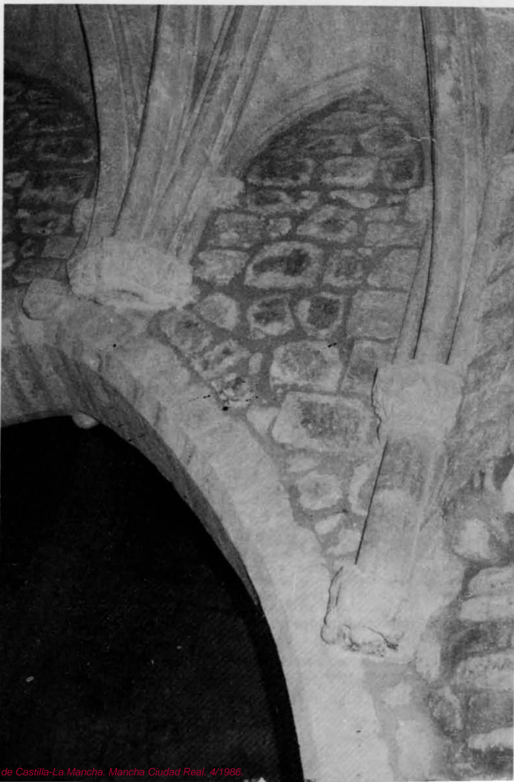
Arco y arranque de bóveda recientemente limpiados.
