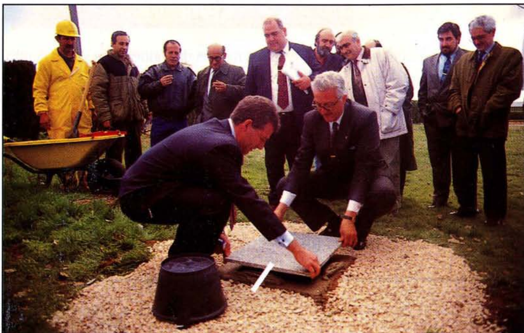
Salvador Galán y Juan Ramirez fueron los encargados de colocar la primera piedra del geriátrico.
