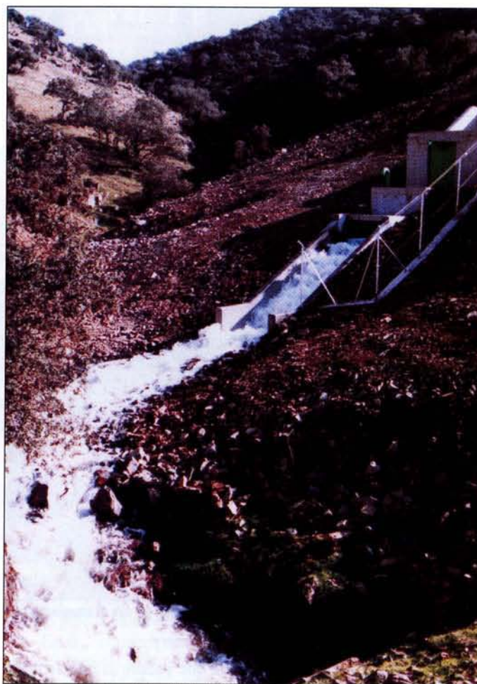
El bombeo desde el Jándula al Montoro comenzó hace dos semanas.
