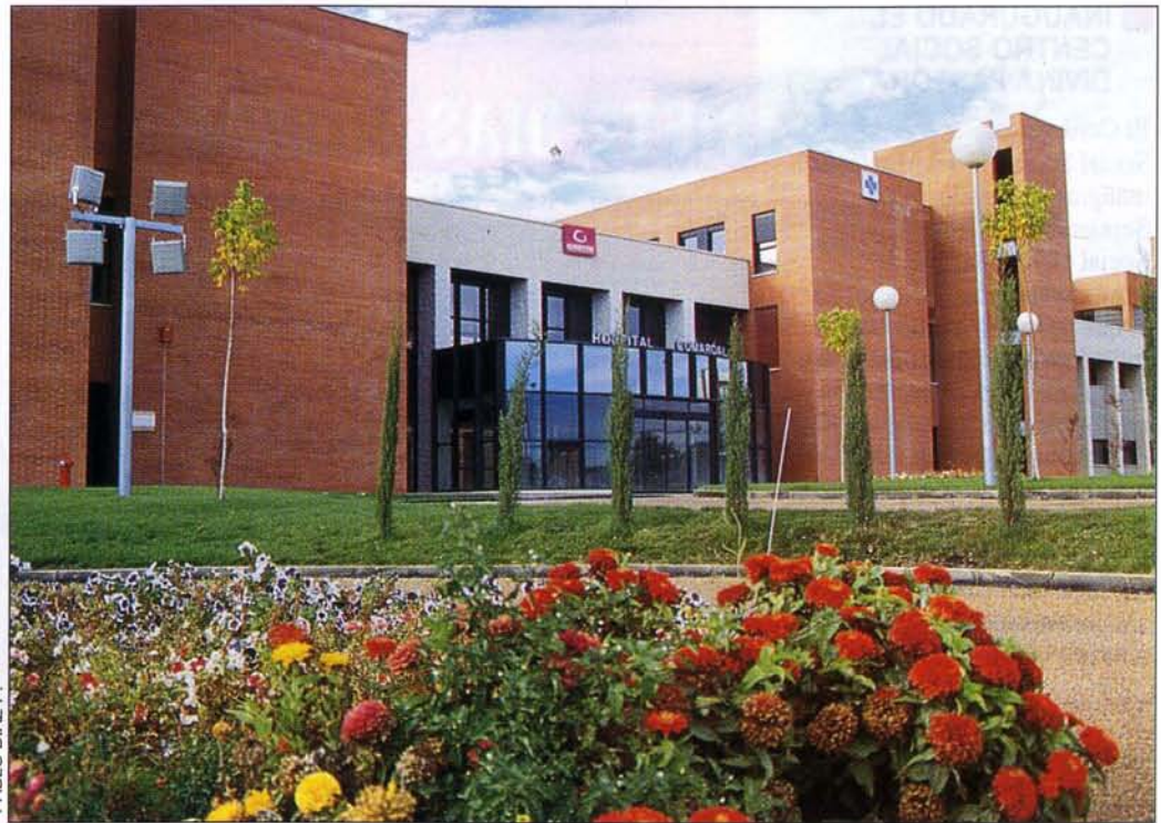
La s obras del hospital de Alcázar de San Juan están, prácticamente, concluidas.
