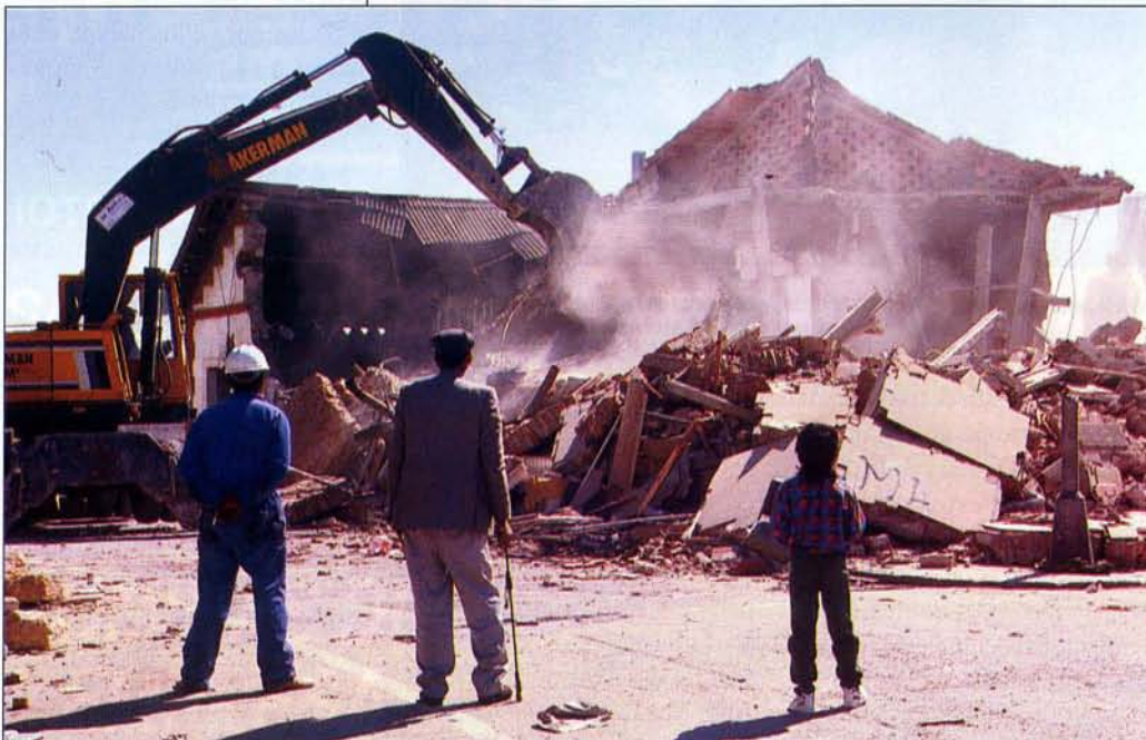
La desaparición de la vieja estación permitirá una mejor comunicación entre la barriada de Larache y el centro de la ciudad.
