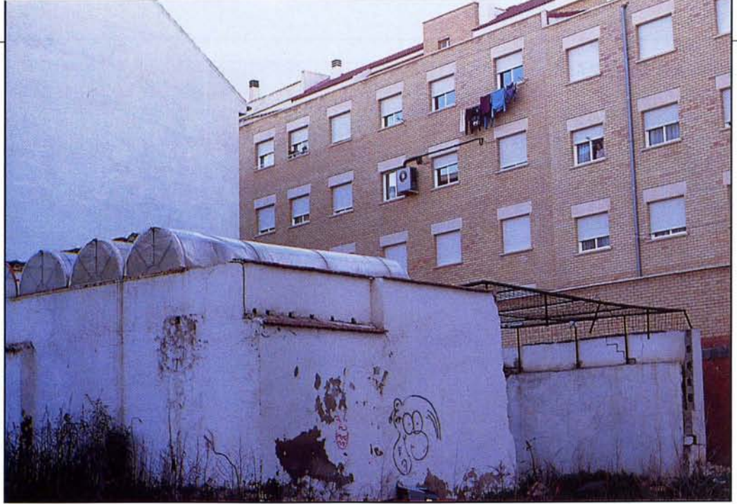
Estos son los restos del Ave Turuta de la calle del Compas, tres años después de que se viniera abajo. Las obras de las edificaciones que se construían cuando se derrumbó concluyeron hace años.
