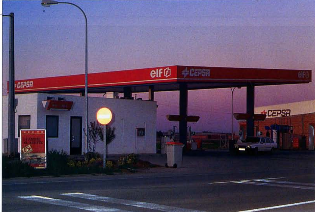
La estación de servicio instalada por Vértice de La Mancha se encuentra ubicada a la entrada de Bolaños según se llega a esta población desde Almagro.
