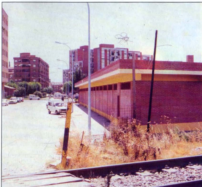
Como se puede apreciar, la puerta de entrada a la piscina está muy cerca de la vía.
