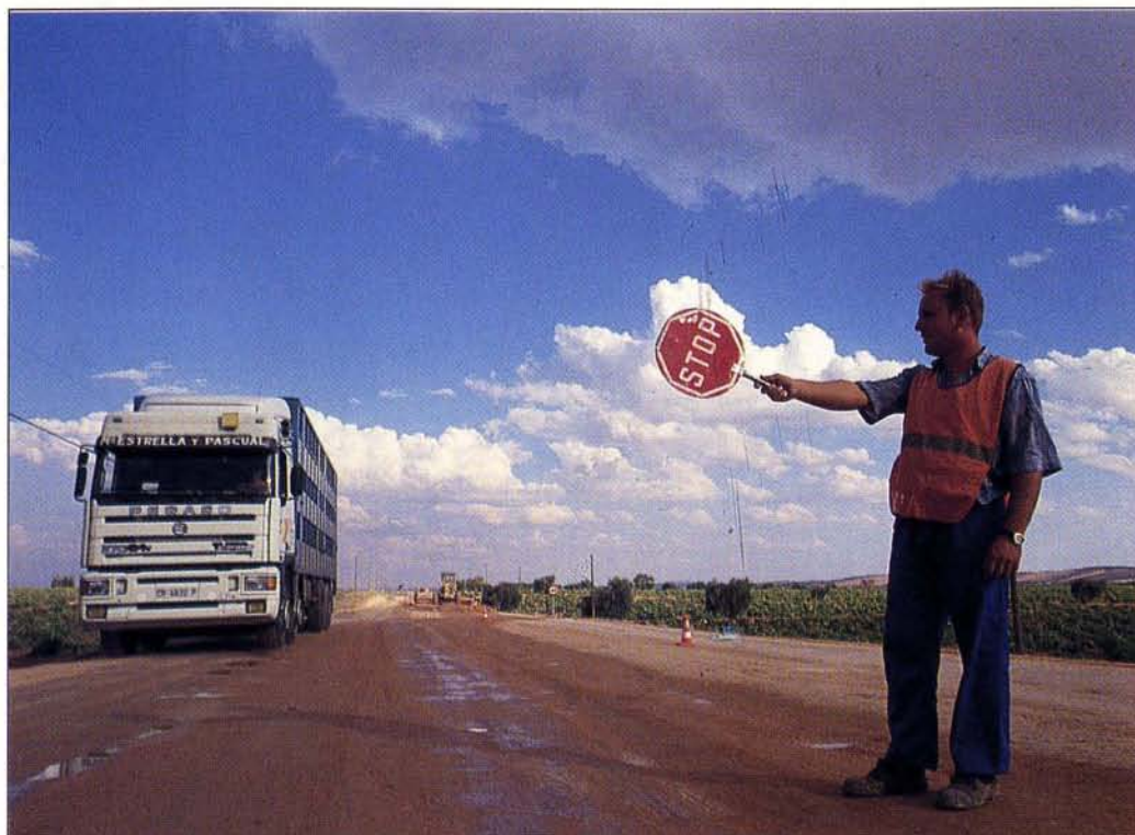
La carretera permanece abierta al tráfico a pesar de las obras
