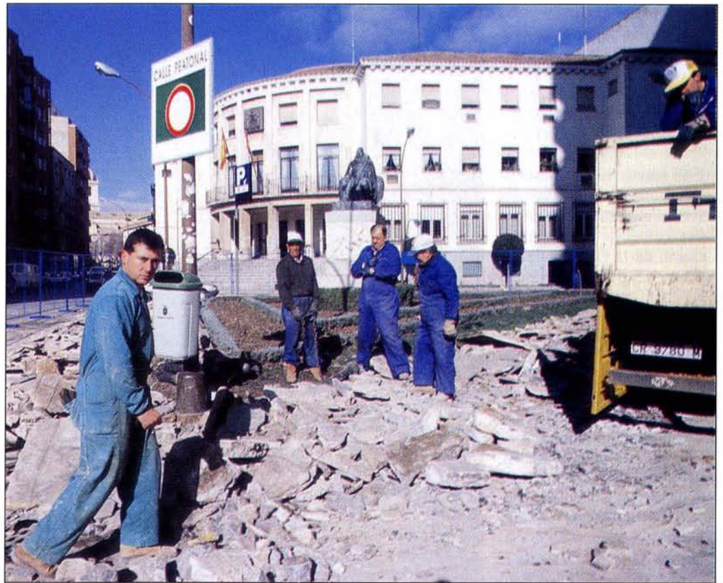
Las obras de remodelación de la plaza de Cervantes comenzaran esta semana y acabaran en seis meses.
