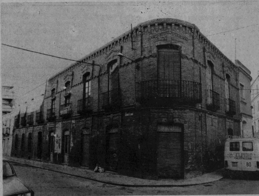
Calle de Ciruela, ladrillo visto aparejado a hueso
