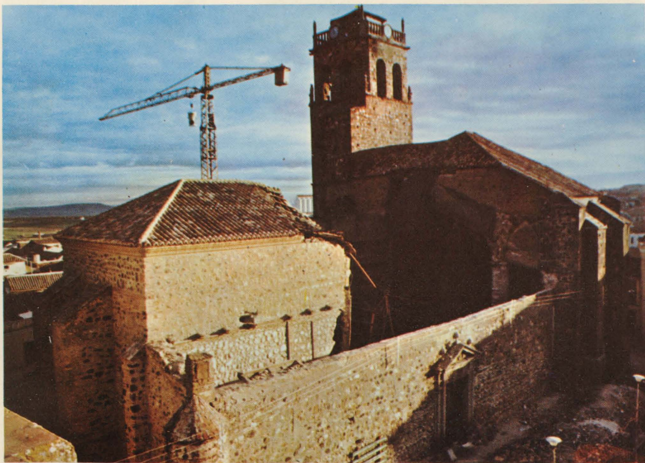
Vista general del edificio a la mañana siguiente del derrumbamiento
