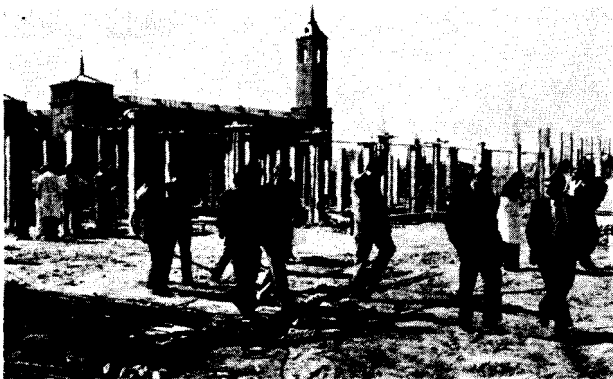
En las obras del nuevo Hospital
